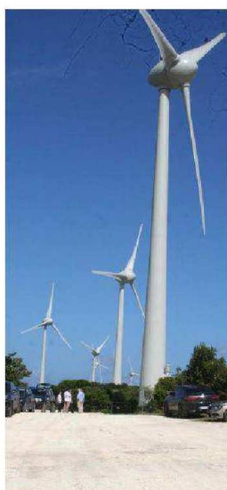
Dix éoliennes plus performantes et adaptées aux intempéries remplacent les 32 installées il y a 20 ans.
